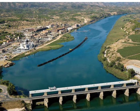
Descontaminación del embalse de Flix en Tarragona
