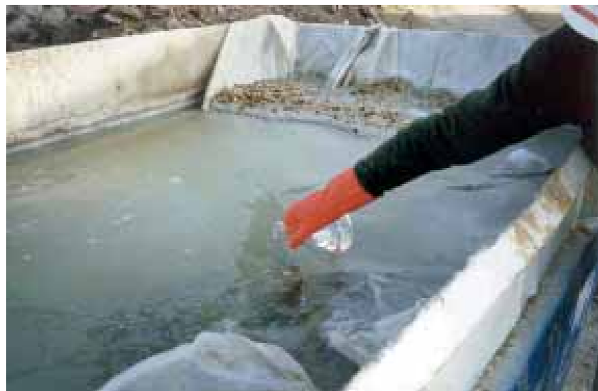
En las obras es preciso en ocasiones neutralizar el agua de lavado de las canaletas de la puesta en obra del hormigón, previamente a su vertido, para reducir el pH (en la foto, 42 viviendas en Puertaldea. Madrid).
