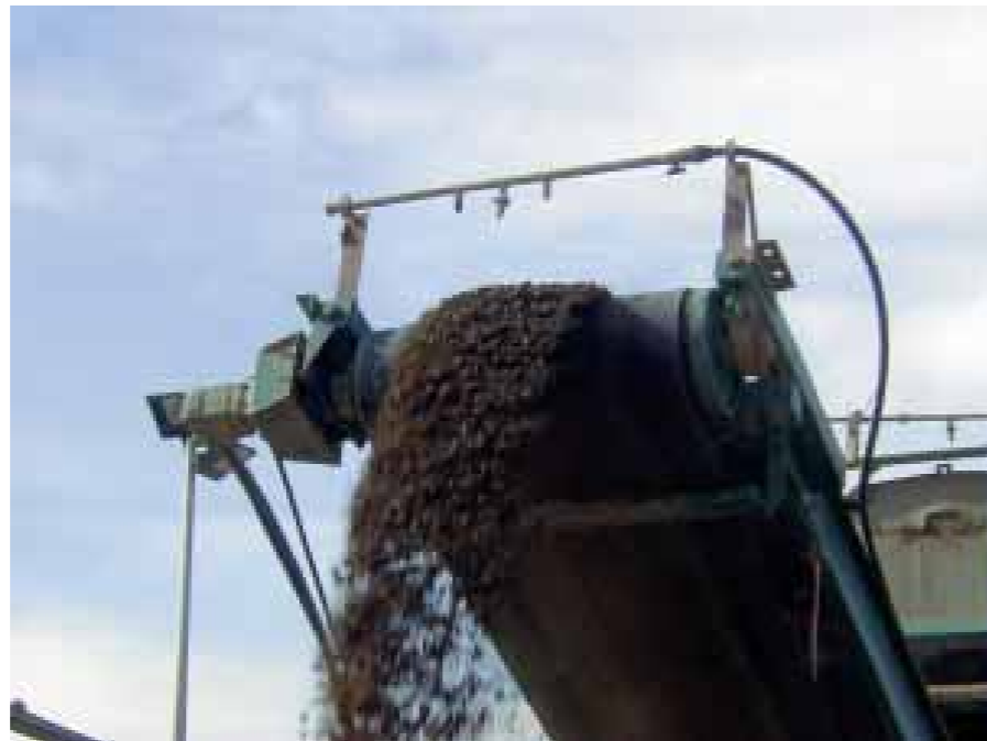
El empleo de aditivos en el agua incrementa muy notablemente la eficacia en la prevención de generación de polvo, como en la ampliación de la plataforma del aeropuerto de Tenerife Sur, donde se emplearon tensoactivos.
