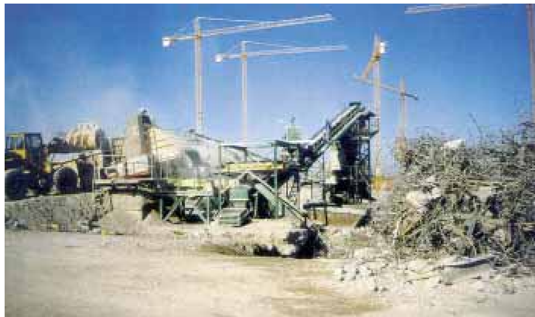
Los escombros procedentes de la demolición de estructuras de hormigón son susceptibles de aprovechamiento, previa separación de la ferralla, para machacarlos y generar áridos, evitando así el consumo de recursos y la necesidad de generar vertedero. En la fotografía aparece la Planta de machaqueo montada en la Urbanización Valderrivas, en Vicálvaro, Madrid, con este objeto.
