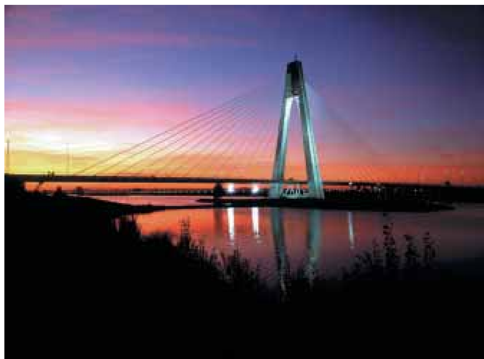
En un entorno urbano la obra civil tiene también su papel. Contribuye a ennoblecer y embellecer el paisaje, aportando elementos de ruptura e hitos de referencia que orientan al transeúnte, definen el escenario y marcan un contexto. [Puente Real de Badajoz].
