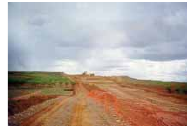
La delimitación física de las zonas que se pueden ocupar y por las que se puede transitar evita una compactación del terreno superior a la estrictamente necesaria, como en este tramo de infraestructuras del GIF en Zaragoza.
