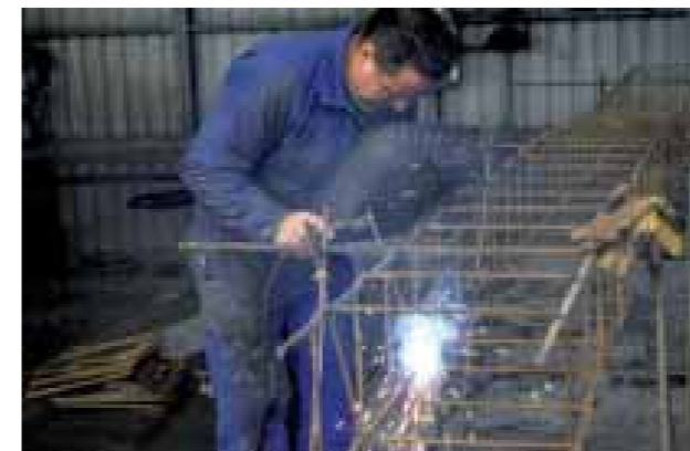
Los subcontratistas son orientados en su actuación medioambiental, y valorados posteriormente con arreglo a su comportamiento. (Nuevo terminal del aeropuerto Madrid-Barajas).
