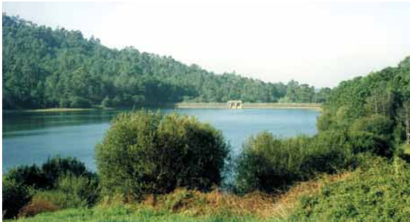
El agua es un bien escaso estrechamente relacionado con nuestra actividad. Es tanto un recurso consumido como el objeto de nuestra intervención, construyendo obras de transporte y regulación, o de depuración. (Presa de Zamares de Vigo).
