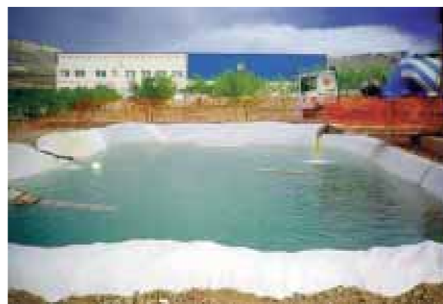
El agua procedente del lavado de cubas y canaletas se reutiliza, en las obras del tramo del AVE Calatayud - Ricla, para las siguientes amasadas de hormigón, tras una decantación.
