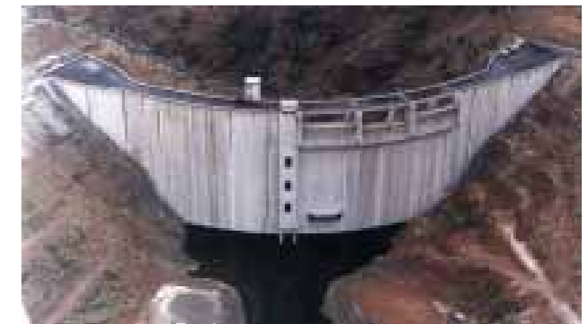
Presa de Casasola. Almogía (Málaga). En ocasiones hay determinadas infraestructuras que son necesarias pero que es preciso integrar de forma particularmente cuidadosa en su entorno.
