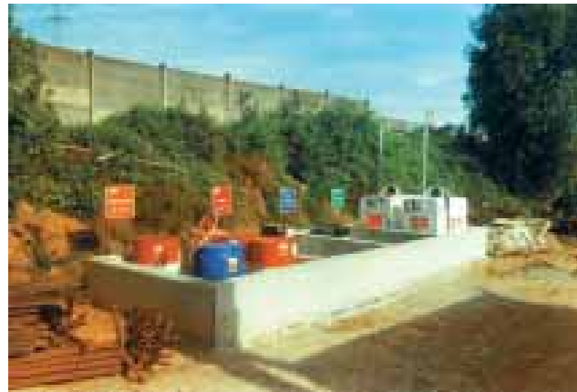
El acopio tanto de sustancias como de residuos peligroso se realiza en el interior de cubetos dispuestos al efecto, con identificación inequívoca de los contenidos y peligros que cada acopio supone, evitando riesgos innecesarios tanto personales como al Medio Ambiente (EDAR Sabadell).
