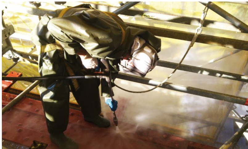
Lavado de la estructura metálica del viaducto
