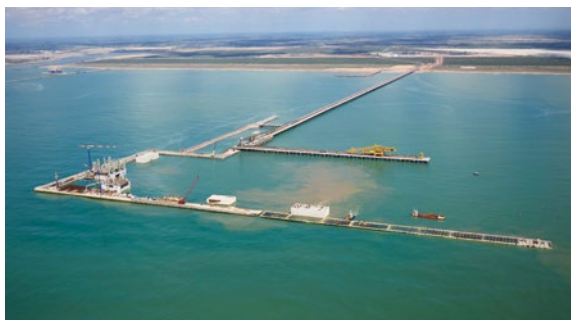
● Construcción de la escollera de Puerto Açu, en Río de Janeiro (Brasil)
