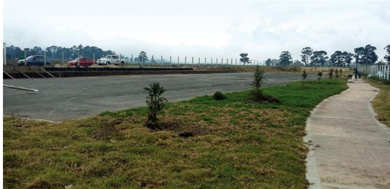
Construcción del Parque San Nicolás
