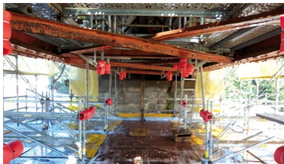
Lavado de la estructura metálica del viaducto
