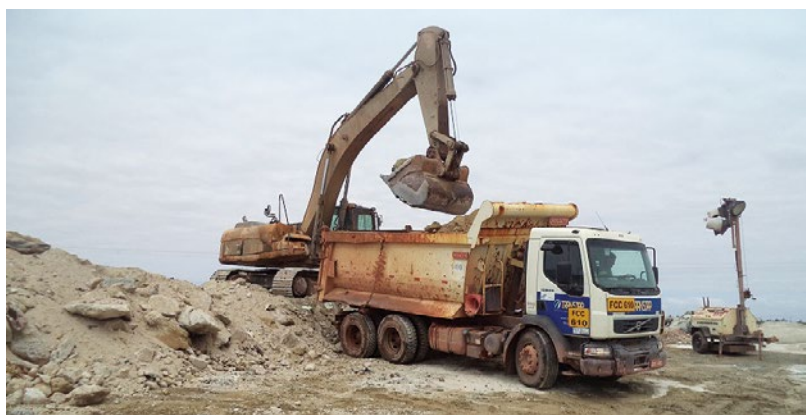
Recogida del material de desecho preparado para la obra
