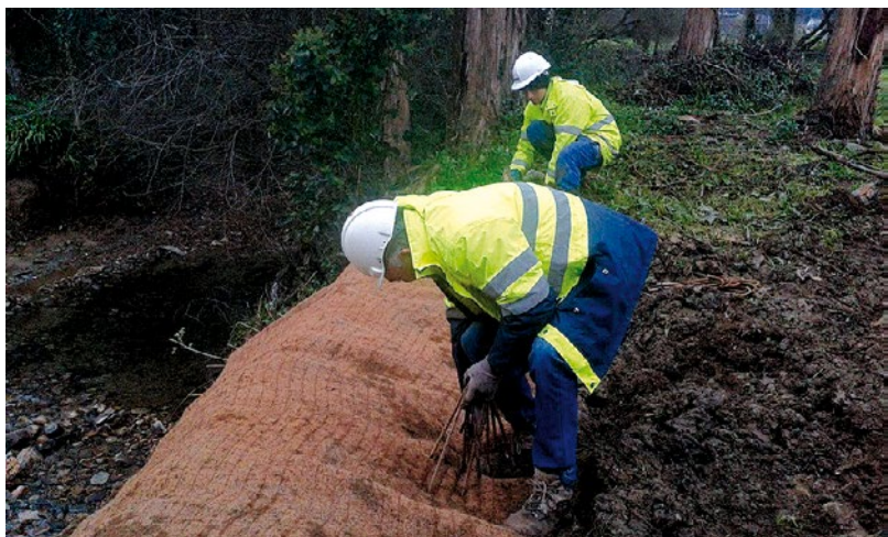
Barrera entre zonas inundables y traza del gasoducto
