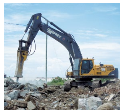
Preparación del material de desecho con excavadora con martillo rompedor
